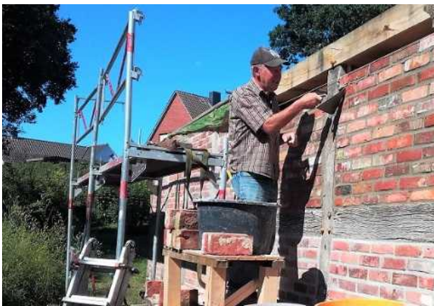
. . . und anschließend verfugt.
