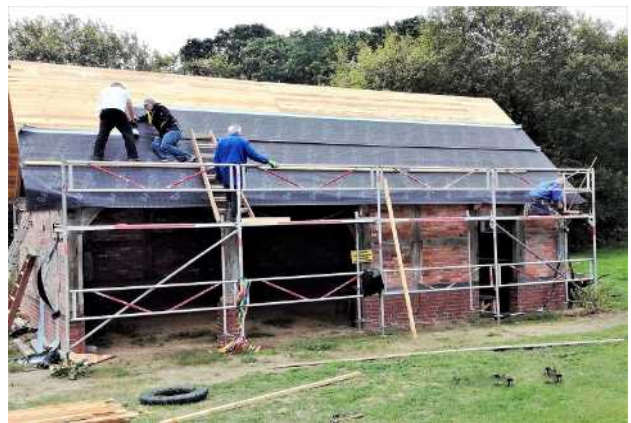
Nicht ganz „ohne“: Dachlatten werden angebracht.
