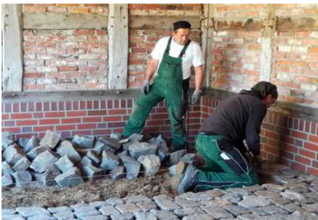
Letzte Arbeiten: Der Boden wird gepflastert.
