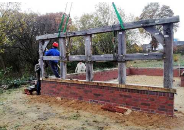
Die erste „Wand“ steht !
