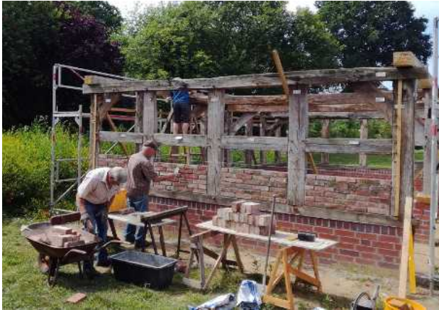
Gefache werden mit alten Steinen ausgemauert . . .
