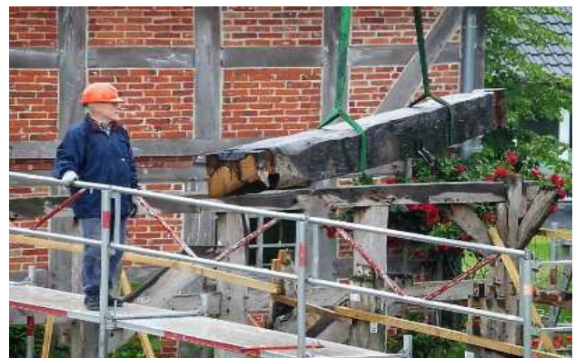
Auch für die Deckenbalken wird der Kran genutzt.
