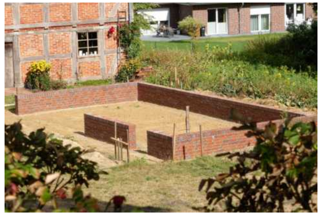
Das Fundament mit dem neuen Sockel ist fertig.
