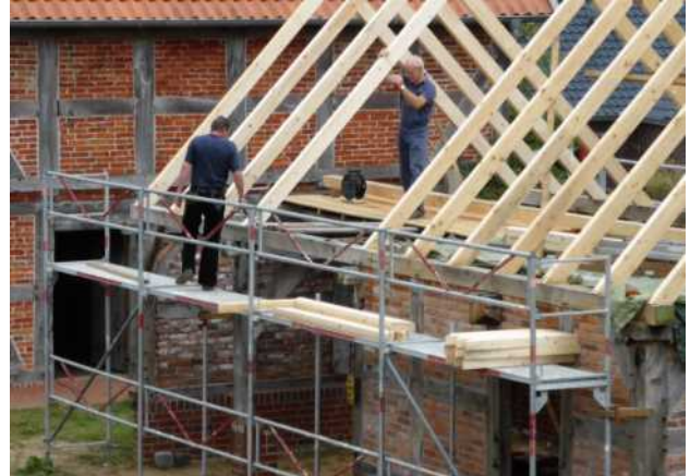
Echte Fachleute errichten die Dachkonstruktion.
