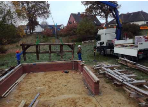
Das Fachwerk wird mit einem Kran aufgesetzt.
