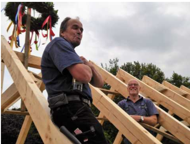
Das Werk ist vollbracht - das Dach steht !
