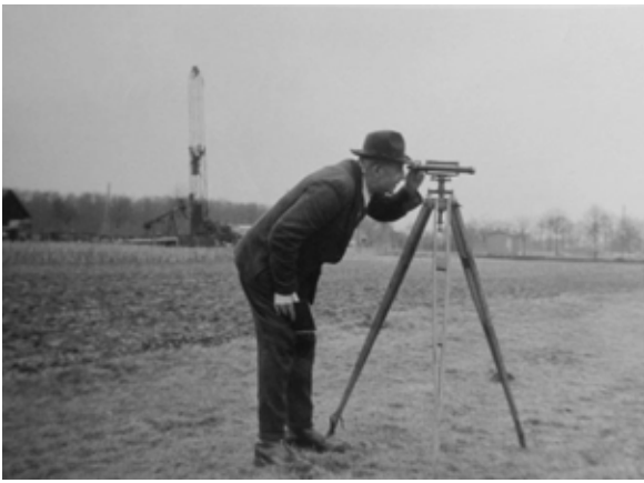
ca. 1958 Vermessungsingenieur mit Nivelliergerät im Ölfeld Aldorf
