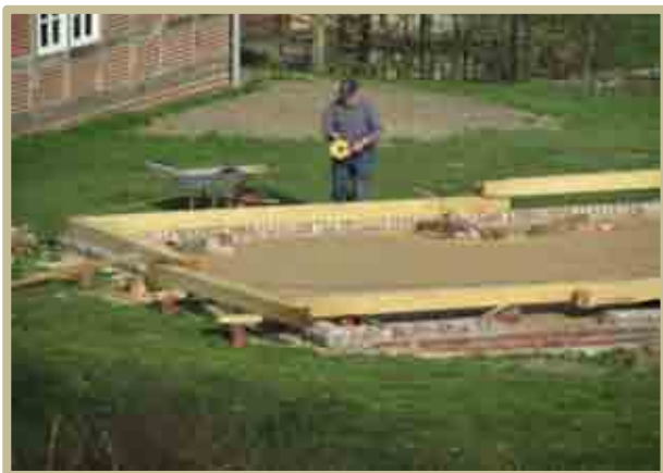
26. März 2012 Das Fundament ist fertig, die Schwellbalken werden angepasst
