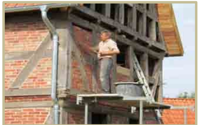
August 2012 Die Gefache werden ausgemauert
