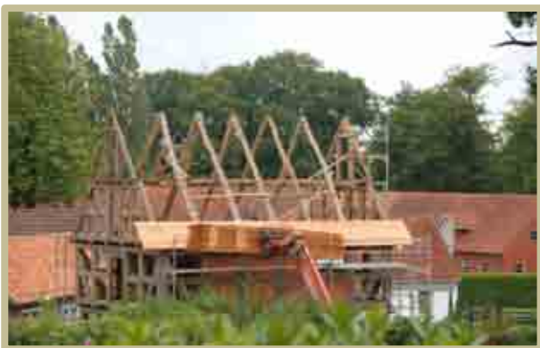
11. Juli 2012 Das „Bremer Dach“ wird erstellt
