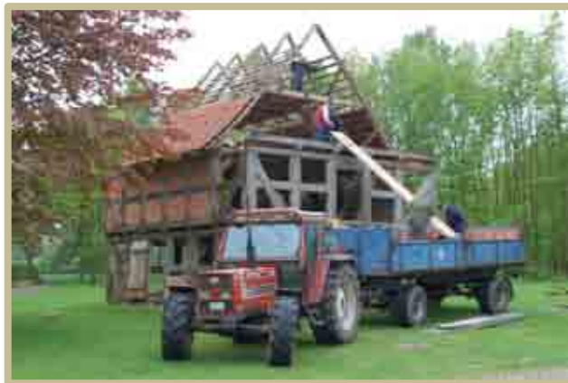
05. Mai 2012 Die Dachziegel werden abgenommen
