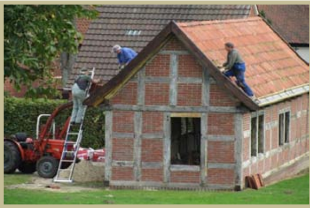
Oktober 2012 Das Dach der Stellmacherwerkstatt wird eingedeckt
