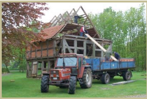
Mai 2012 Die Dachziegel werden abgenommen
