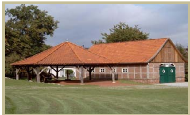
2007 Göpel und Scheune sind aufgebaut
